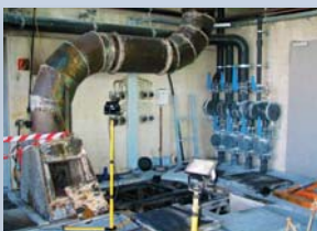
Brandschaden durch Feuerarbeiten in einer Absaug- und Kläranlage
