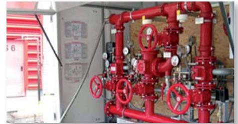
Pumpenstation Sprinkleranlage
